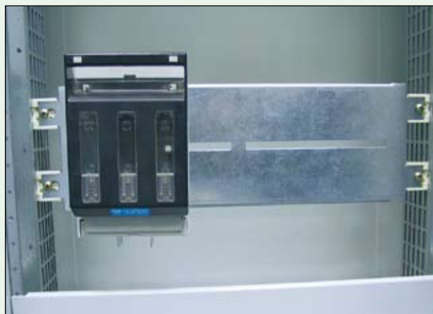
Mocowanie rozłącznika bezpiecznikowego LTS 160/00 na panelu montażowym MPN.../130
