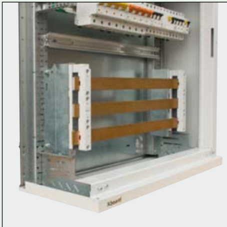
Widok zestawu dla izolatorów 3-bieg. zainstalowanych na profilach ściany tylnej rozdzielnic BP
