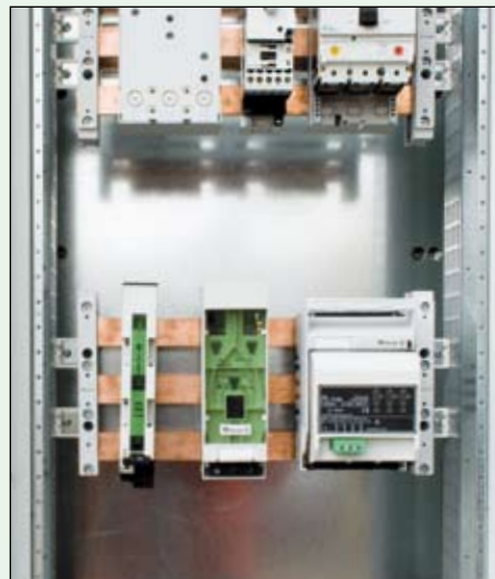
Widok zainstalowanych bezpieczników rozłącznikowych typu NH-SLS-00/160, LTS-100/C00/3-R i GST-00 z osłoną do kontroli bezpieczników typu GST00-DSI
