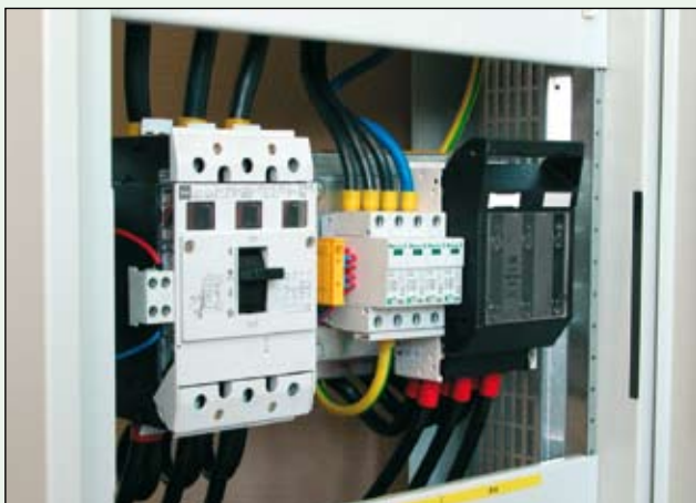
Montaż rozłącznika na panelu MPN 130 mm. Na panelu zamontowana została również szyna nośna TSA z ogranicznikiem przepięć klasy C
