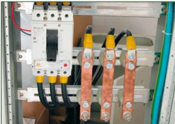
Montaż wyłącznika PMC2 w rozdzielnicy szerokość 2 na panelach montażowych MPN 2/050
