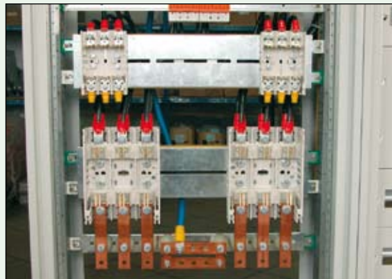
Montaż rozłączników bezpiecznikowych w rozdzielnicy szerokość 3
