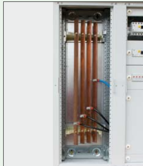
Widok kanału kablowego z zastosowaniem izolatorów typu BPZ-BBS-4/630 na wspornikach BPZ-MPL80
