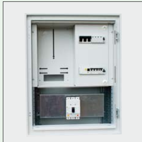
Widok kasety licznikowej BPZ-MT-... wraz z zestawem dla aparatury modułowej typu BPZ-DRS-MT/400-1 zainstalowanej w rozdzielnic typu BP
