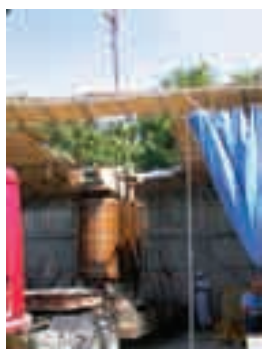
Przykład: Transformator Piecowy gruntowne naprawy na miejscu Example: Furnace Transformer overhaul repairs on site
