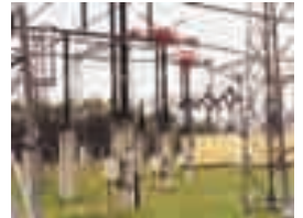
Po modernizacji After modernisation
