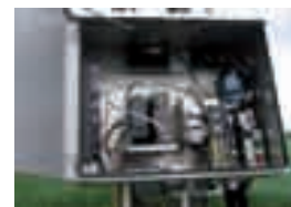
Napęd silnikowy typu UEMC 50 przystosowany do sterowania radiowego Motor operating mechanism type UEMC 50 adopted for
