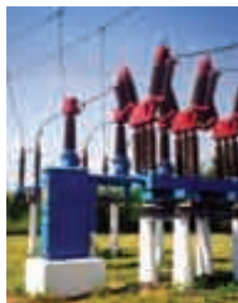
Wymiana na nowy Wyłącznik typu EDF – 123 kV Replacement for new Circuit Breaker type EDF – 123 kV
