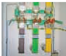
Wymiana odłącznika z napędem pneumatycznym Replacement of disconnector fitted with a pneumatic operating mechanism
