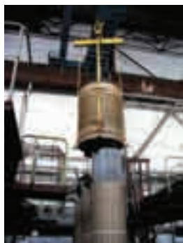
Przykład: Transformator Piecowy - wymiana uzwojenia Example: Furnace Transformer - winding replacement
