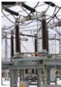
Wpasowanie nowego odłącznika typu ONIII-123 kV Fitting of new disconnector type ONIII-123 kV
