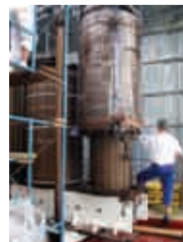
Wymiana uzwojeń Winding replacement
