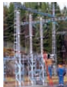
Wyłącznik typu LTB – 145 kV Circuit Breaker type LTB – 145 kV
