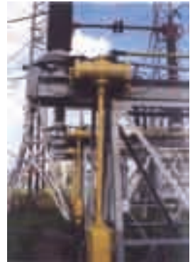
Przed modernizacją Before modernisation
