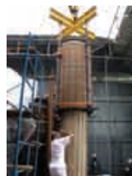
Wymiana uzwojeń Winding replacement
