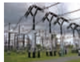
Wyłącznik typu DLF – 420 kV Circuit Breaker type DLF – 420 kV
