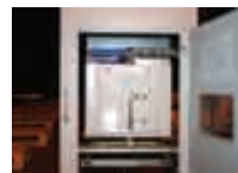
Przygotowany człon ruchomy wyłącznika typu VD4 do rozdzielnicy typu RD1 Movable module of a circuit breaker type VD4 prepared for switchboard type RD1
