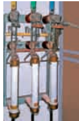
Wymiana rozłącznika liniowego typu OR 24-300/1 i uziemnika UW III 20-1 na rozłącznik liniowy z uziemnikiem typu NAL Replacement of line switch disconnector type OR 24-300/1 and an earthing switch UW III 20-1 by line switch disconnector with earthing switch type NAL
