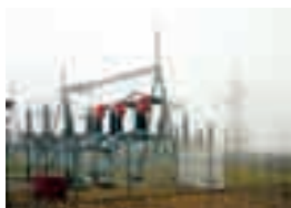
System modułowy typu COMPASS 110 kV COMPASS module system 110 kV
