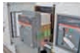
Przykład wyłącznika SACE w pozycji całkowicie wysuniętej Example of SACE circuit breaker in full withdrawal position
