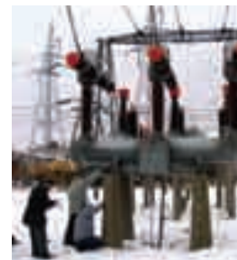
Wyłącznik typu DLF – 123 Circuit Breaker type DLF – 123
