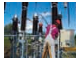
Wyłącznik typu LTB – 145 kV Circuit Breaker type LTB – 145 kV
