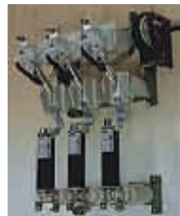
Wymiana rozłącznika z podstawą bezpiecznikową typu LHTCI na rozłącznik z podstawą bezpiecznikową NALF Replacing of switch disconnector with switch fuse combination type LHTCI by switch disconnector with switch fuse combination type NALF
