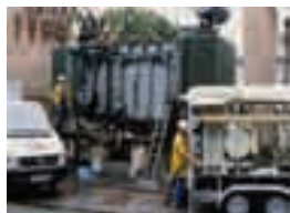
Gruntowny serwis w miejscu zainstalowania łącznie z obróbką i wymianą oleju On site overhaul service including oil treatment and replacement
