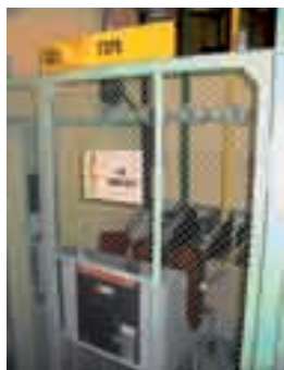
Wyłącznik VD4 w zabudowie pola otwartego rozdzielniczy typu RWS Circuit breaker VD4 fitted in an open switchboard type RSW
