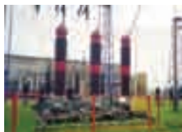
Wyłącznik typu VMM – 110 kV Circuit Breaker type VMM – 110 kV
