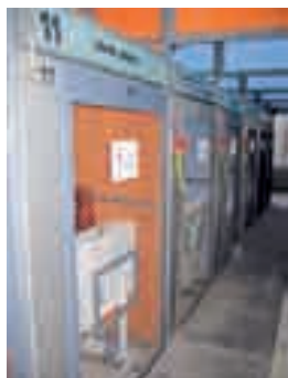
Retrofit rozdzielnic SN MV switchboard retrofit
