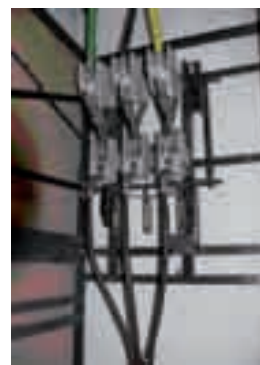
Wymiana rozłącznika liniowego typu OR 24-300/1 i uziemnika UW III 20-1 na rozłącznik liniowy z uziemnikiem typu NAL Replacement of line switch disconnector type OR 24-300/1 and an earthing switch UW III 20-1 by line switch disconnector with earthing switch type NAL
