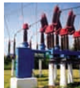
Wyłącznik typu WMS – 110 kV Circuit Breaker type WMS – 110 kV
