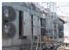
Instalacja i odbiór końcowy z podaniem napięcia Installation and final commissioning with energizing
