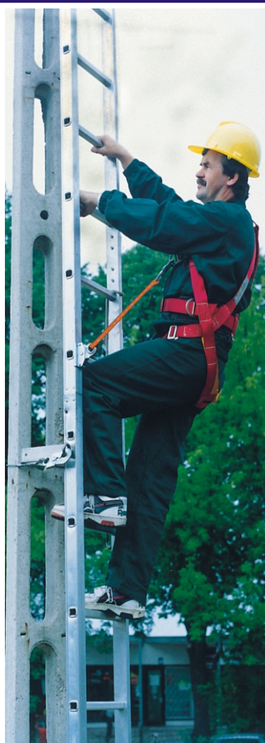
1. Drabina z urządzeniem USM-1 zabezpieczającym przed upadkiem z wysokości
