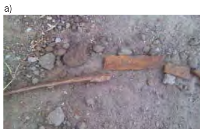
Rys. 9 Prawidłowo wykonane połączenie uziomu sztucznego (system pomiedziowany GALMAR) z uziomem fundamentowym
