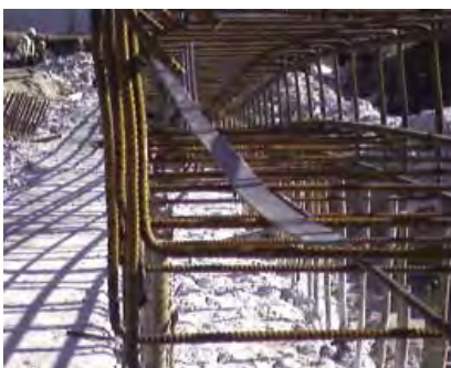
Rys. 6. Zalecane wykonanie uziomu fundamentowego z wykorzystaniem taśmy stalowej (za zgodą RST Sp. j.)
